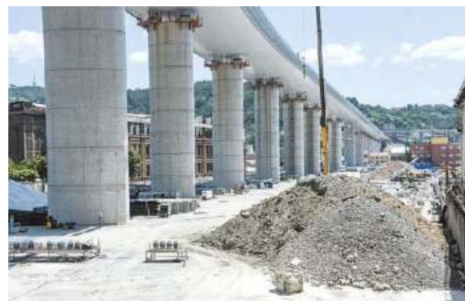
L'immagine del ponte ripreso da ponente
