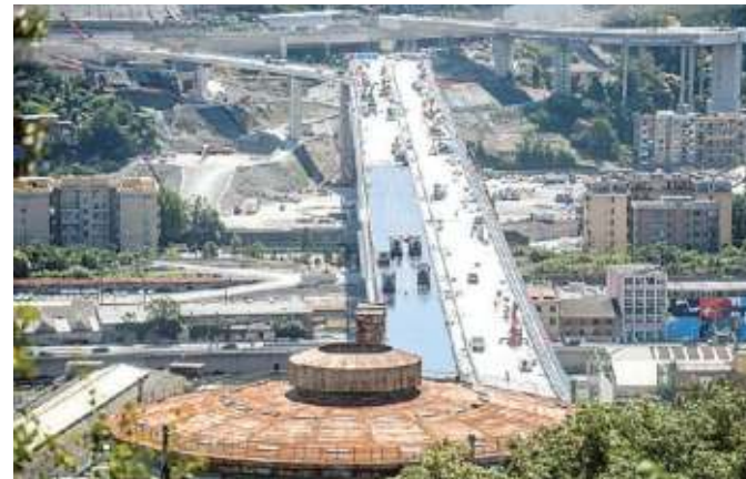
Il viadotto dopo le ultime pavimentazioni
